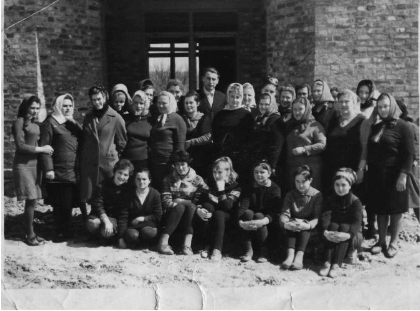
(Фото : суботник на будівництві інфекційного відділу лікарні. Головний лікар Нешик В. І з медпрацівниками)
